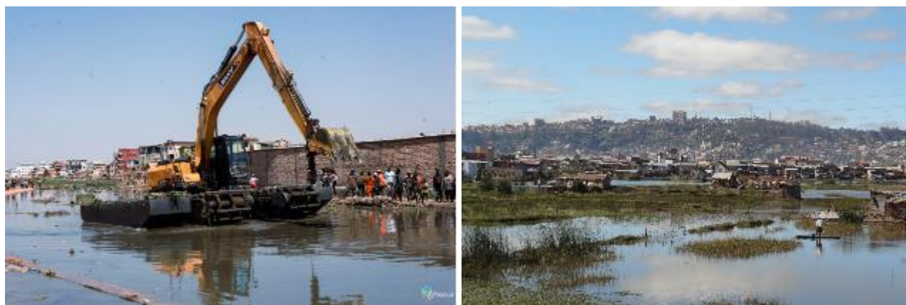
Photographie 13 : Curage du Canal C3 (à gauche) et zones marécageuses (à droite)
