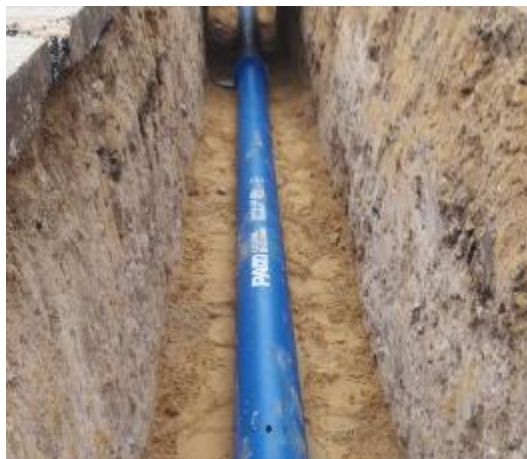
Photographie 5 : Conduites en fonte ductile destinées à l'alimentation en eau potable
