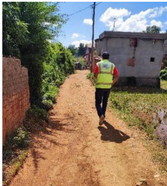
Photographie 9 : Tranchée sous chemin de terre
