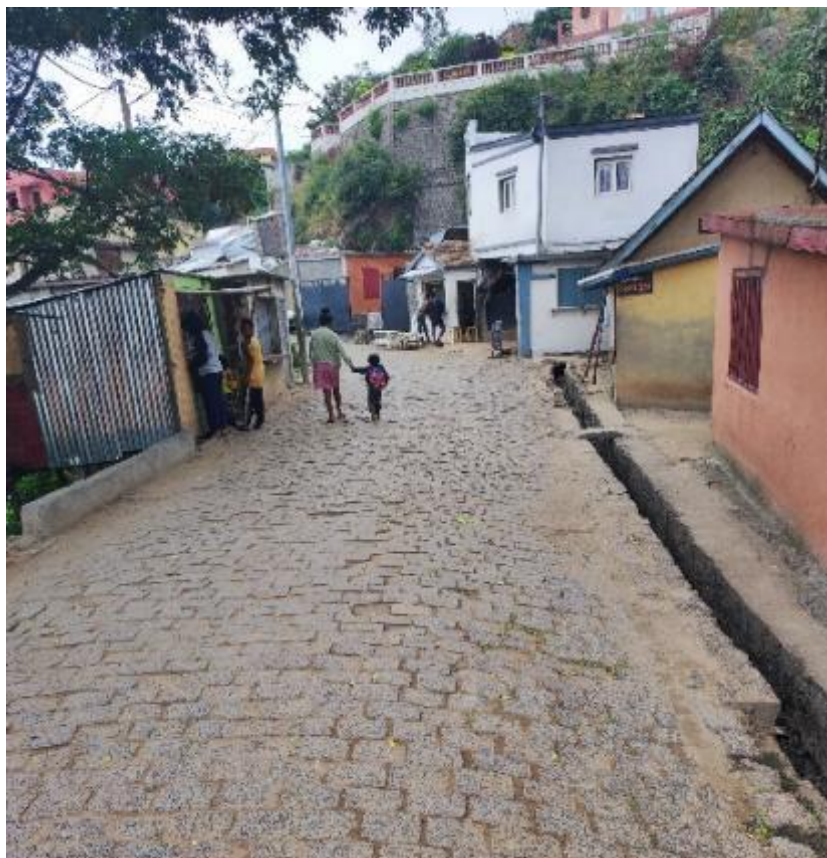
Photographie 7 : Tranchée opérée sous voirie pavée
