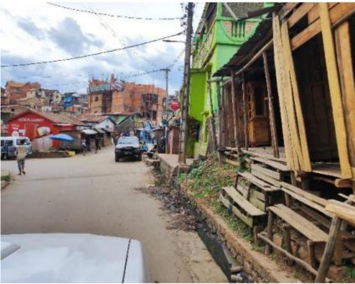
Photographie 6 : Tranchée opérée sous voirie enrobée
