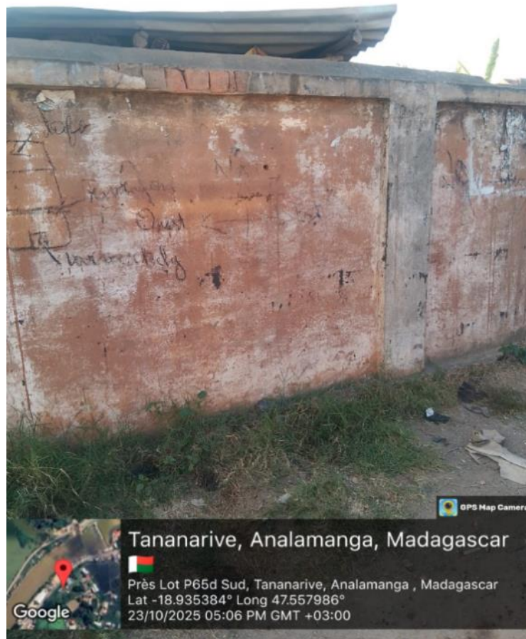
Figure 2: Construction à Ankadindratombo
